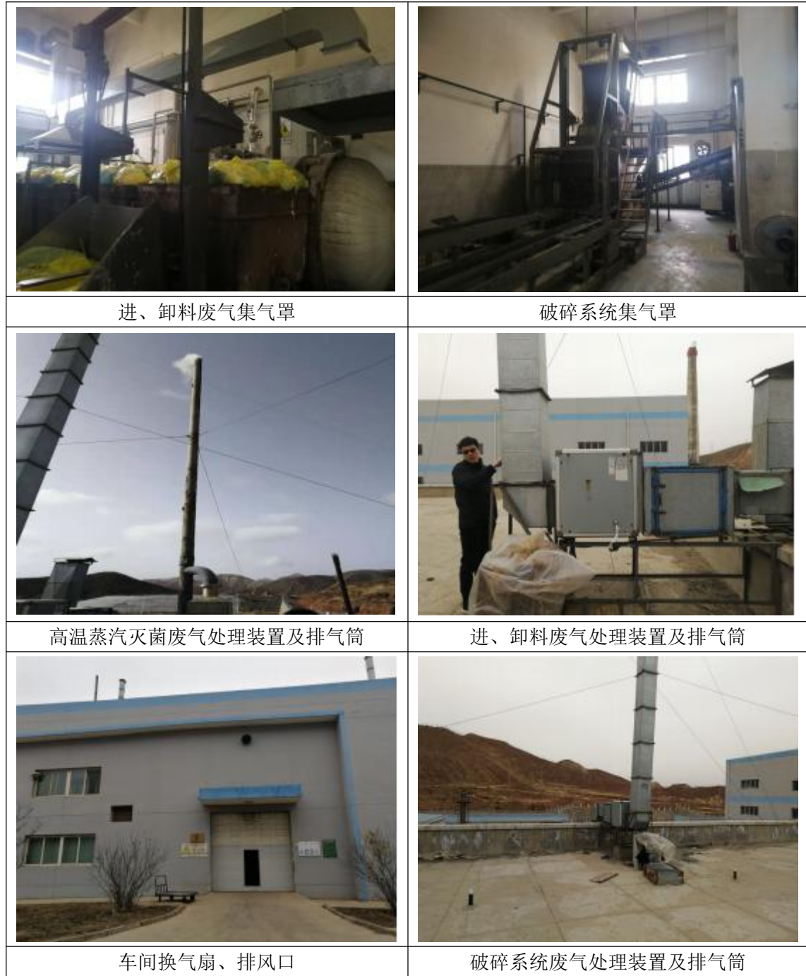
图 2.2-4 高温灭菌车间废气收集治理措施及排气筒
